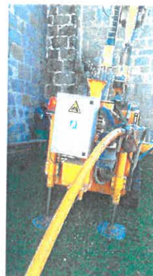
Engin de forage pour l'installation du paratonnerre
