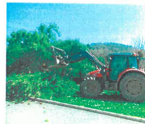
Sécurité : abattage sapin cour d'école
