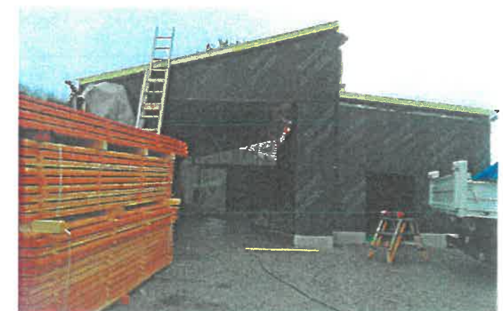
L'atelier communal en cours de chantier
