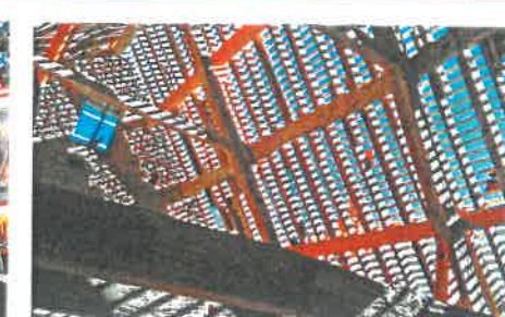
Charpente de l'Église en refecton
