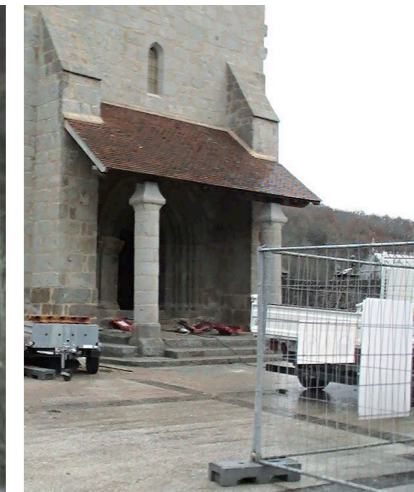
Fin des travaux de l'église
