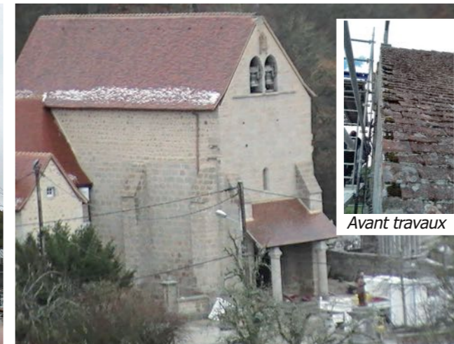
Toiture et maçonnerie refaite
