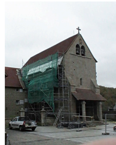
Dernier mur en chantier
